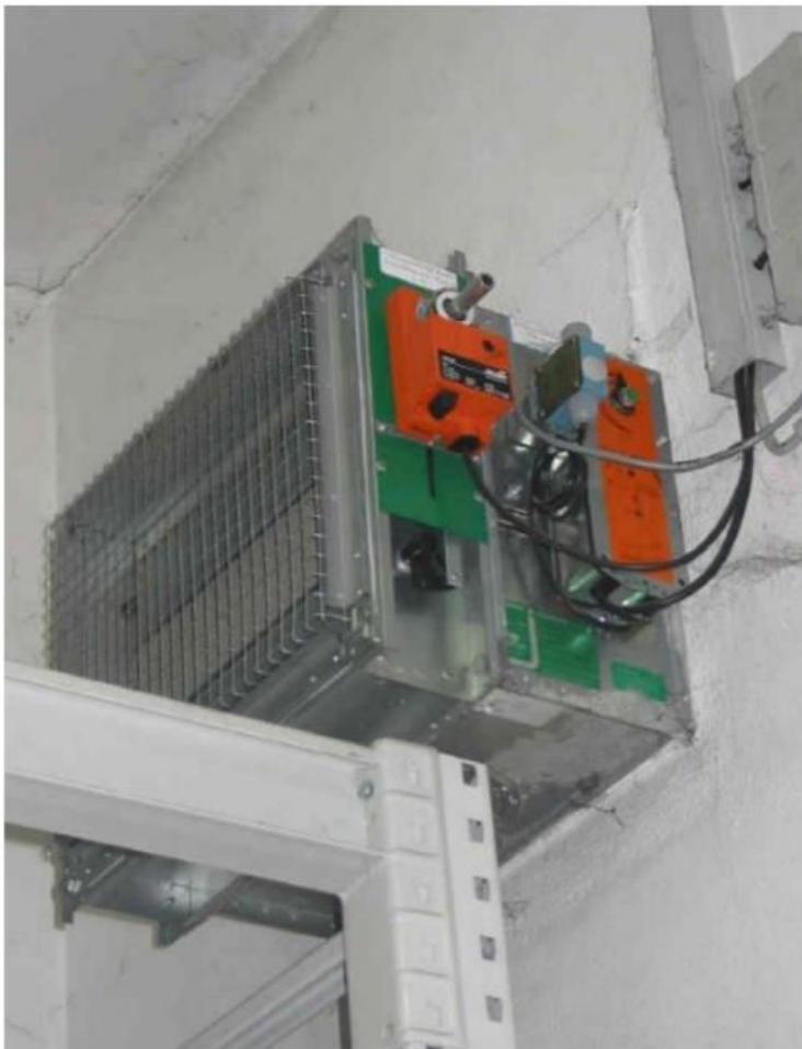
**Bild L1:** Brandschutzklappe K90
